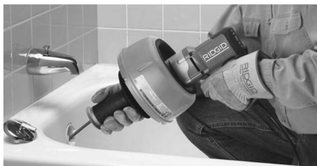
Obrázok 9 – Zatláčanie kábla do potrubia odtoku
