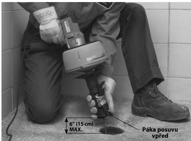
Obrázek 10 – Protlačení kabelu pomocí AUTOPOSUVU
