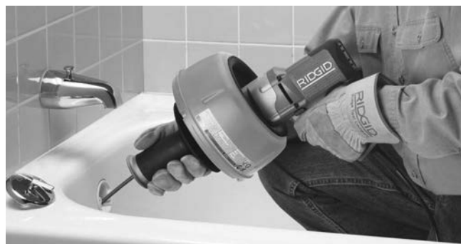
Рис. 9 – Протолкните трос дальше в канализационную трубу
