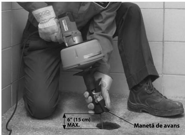
Figura 10 – Avansarea cablului cu AUTOFEED
