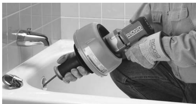
Slika 9 - Gurnite sajlu niz odvod
