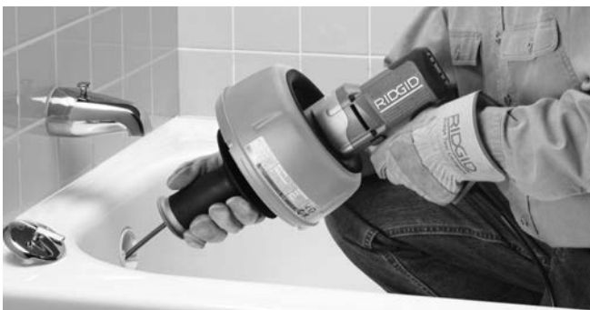
Figure 9 – Pousser le câble dans la conduite
