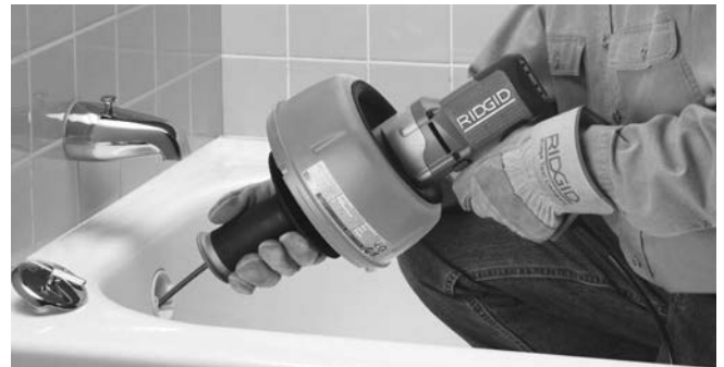
Abbildung 9 – Spirale in den Abfluss schieben
