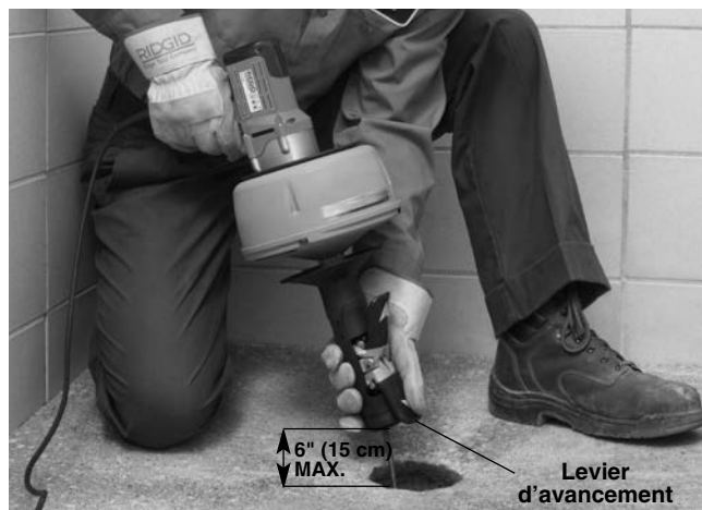
Figure 10 – Avancement du câble à l'aide du système AUTOFEED
