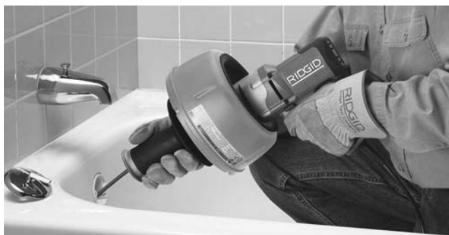
9. ábra – Tolja a lefolyóba a kábelt
