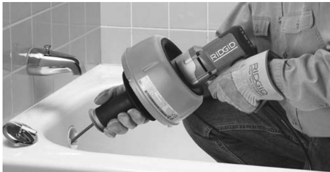
Figuur 9 – Duw de veer in de afvoerleiding
