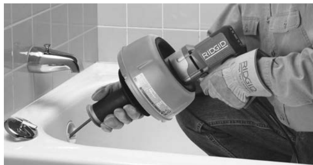
9-сурет – Кабельді ағын желісінен өткізу
