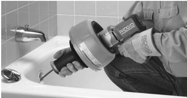
Figur 9 – Skjut spiralen längs avloppsledningen
