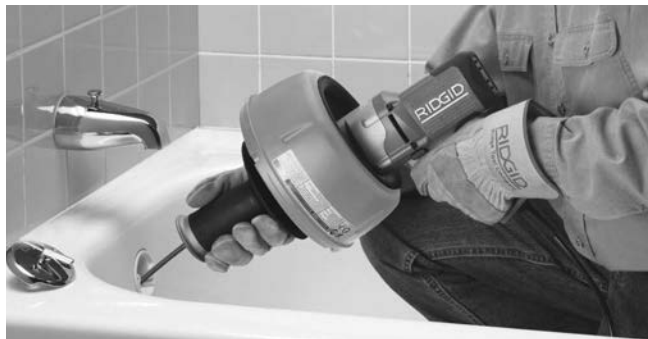
Figura 9 – Împingeți cablul de-a lungul conductei de canalizare
